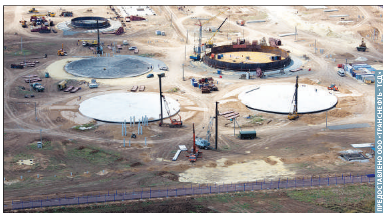
ГПС «Тингута» - уникальный объект, на котором строятся 4 резервуара для дизтоплива емкостью по 20 тыс. тонн, 2 резервуара для аварийного сброса дизтоплива, 2 пожарные емкости, 4 резервуара для хозяйственных нужд и 34 здания
