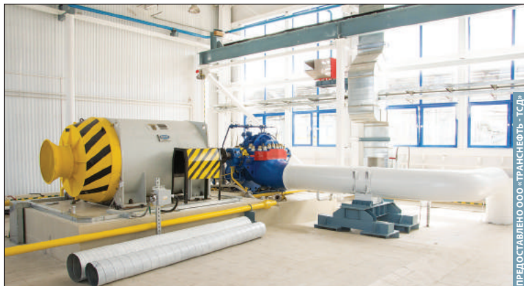
Магистральная насосная МНС-5 ПНБ «Тихорецкая» оснащена четырьмя российскими насосными агрегатами мощностью по 2 МВт и способна перекачивать 19 млн тонн нефти в год
