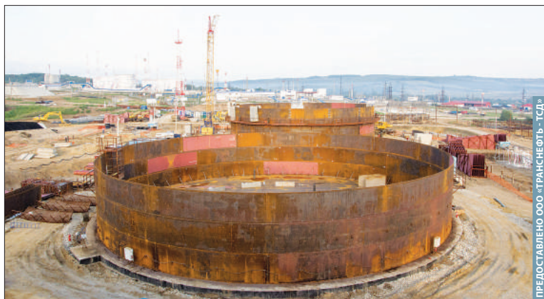
Строящиеся на ЛПДС «Крымская» резервуары РВСП-20000 успешно прошли контроль методом наземного трехмерного лазерного сканирования
